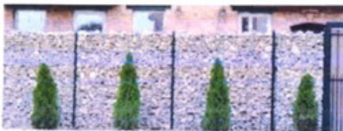
Clôture ne pouvant pas être acceptée en limite de voirie (base structurelle : clôture grillagée !)
