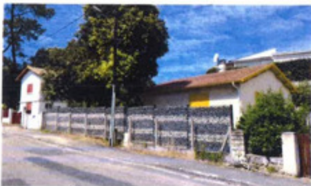
Clôture existante à Saint-Palais :
