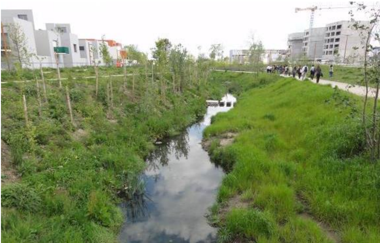
Exemples de bassins de gestion des eaux pluviales paysagés et aménagés comme espaces de convivialité
